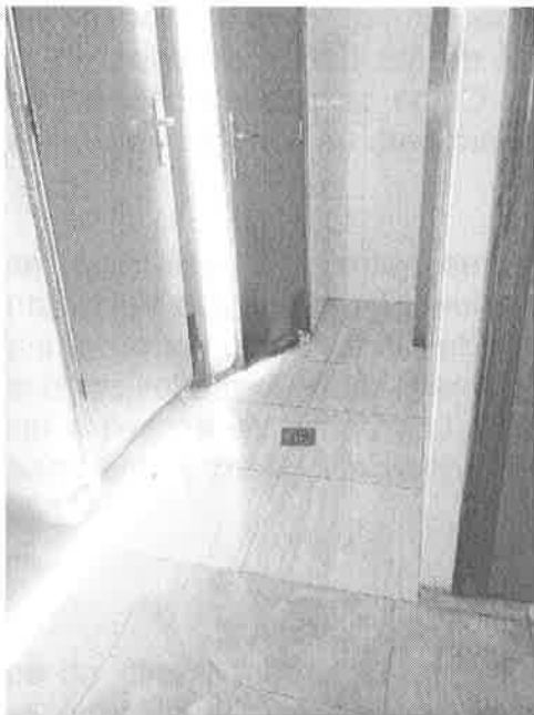
Foto 1. Carpinterías cabinas sanitarias.
