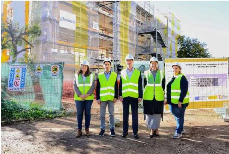
Visita a les obres de reforma del mòdul D de la Llar d'Ancians
